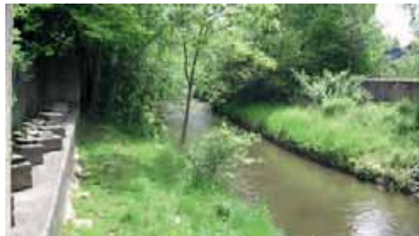
Nachhaltige Planung Brückenfundamente, ursprünglich von der Haarener Allee, sollen für die Einrichtung der Fuß- & Radwegebrücke wieder in Funktion genommen werden.
